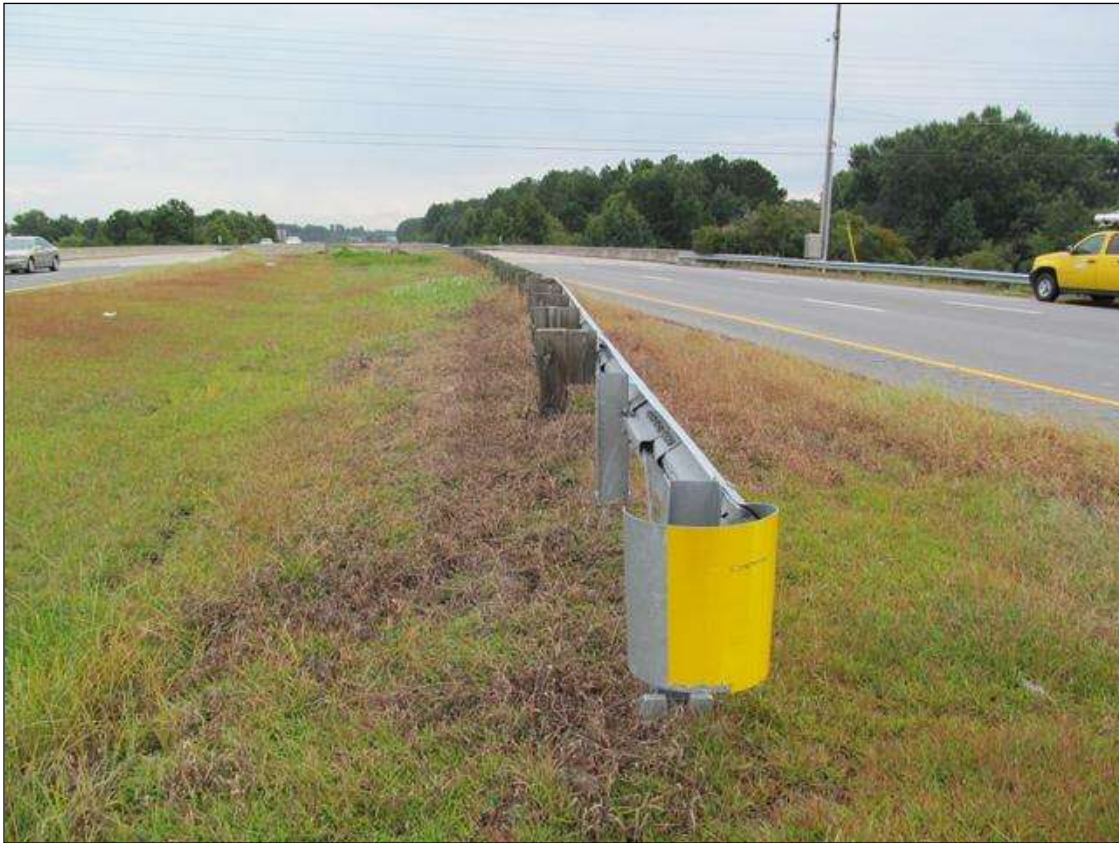
NW GUARDRAIL END TERMINAL. (SW & SE ENDS SIMILAR)
